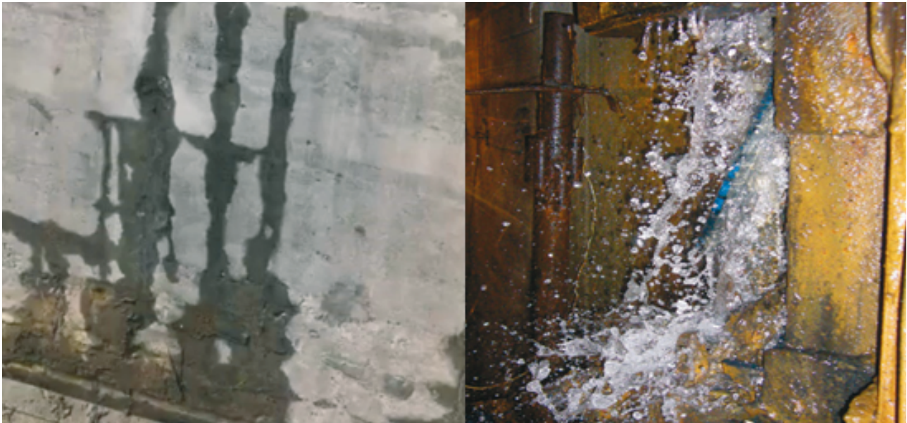
Рисунок 7.2.1 – Безнапорная и напорная течи
